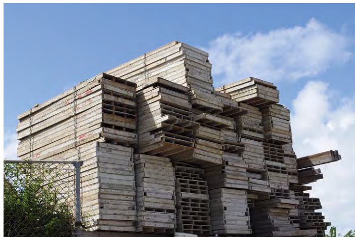
打設が終わり廃棄されるコンパネ型枠
