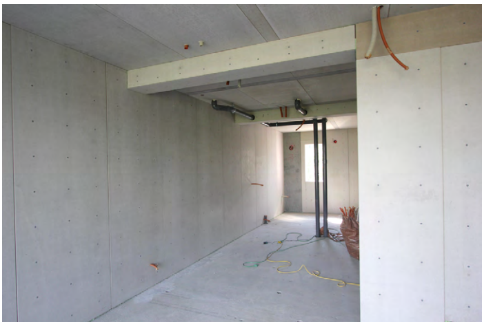
打設後の内部ゼロボード打ち放し状況
