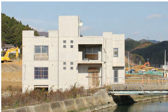
ただ1軒のみ残された状況
