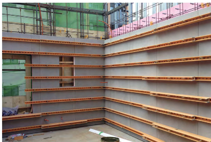
バタ取付状況
