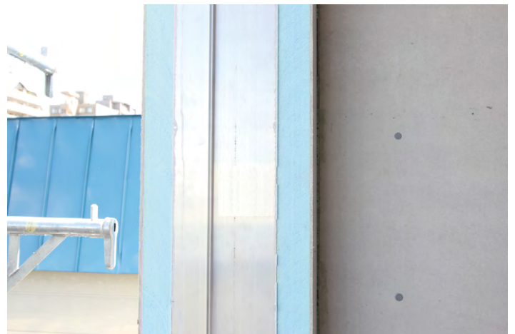
打設後の躯体開口部
