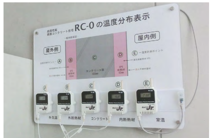
躯体内温度計測機による測定状況
