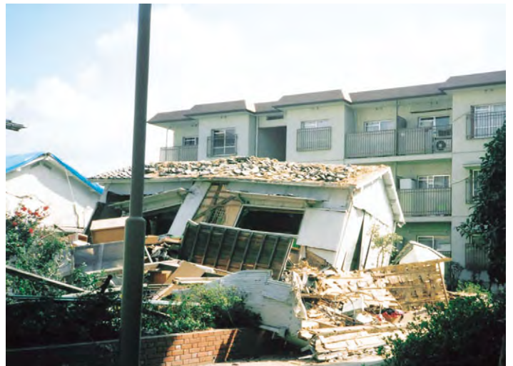
阪神淡路大震災で倒壊した木造軸組み住宅（手前）と、無傷の壁式鉄筋コンクリート造アパート
