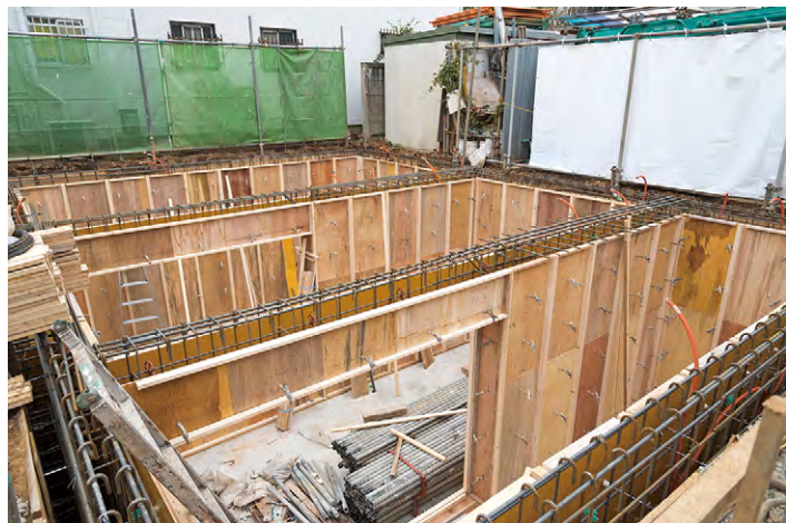
コンパネ型枠の建て込み状況
