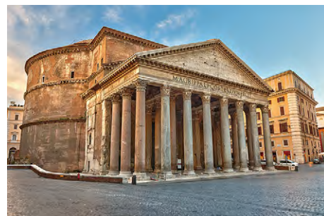
紀元前25年 パンテオン（イタリア） 幾多の災害や大地震にも2000年以上耐えて現存するコンクリート建築（鉄筋無し）
