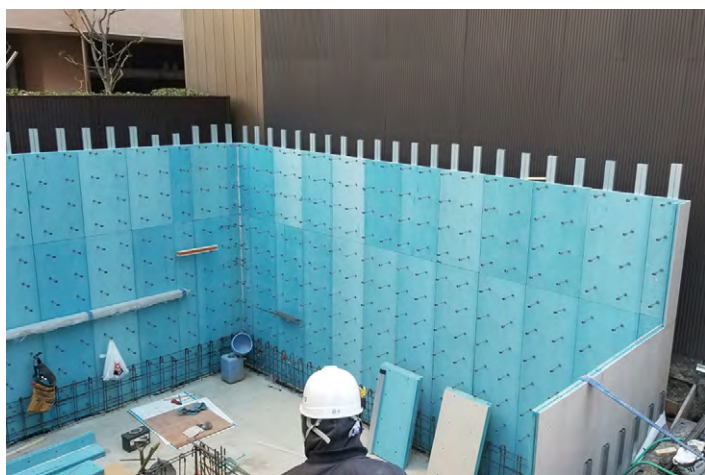
ゼロボード建て込み状況
