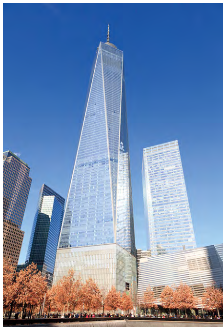
20世紀 One World Trade Center（アメリカ） 悲劇を乗り越え、鉄骨造から頑丈な鉄筋コンクリート造に建て替えられた
